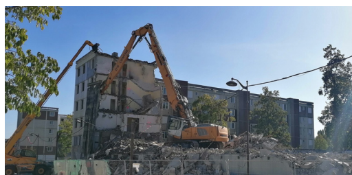
Photo - Démolition rue Paul Verlaine - Val de Berry
